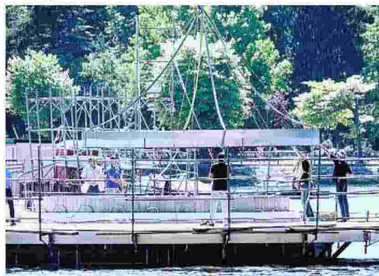
La posa del cerchio di acciaio, base dell'opera
